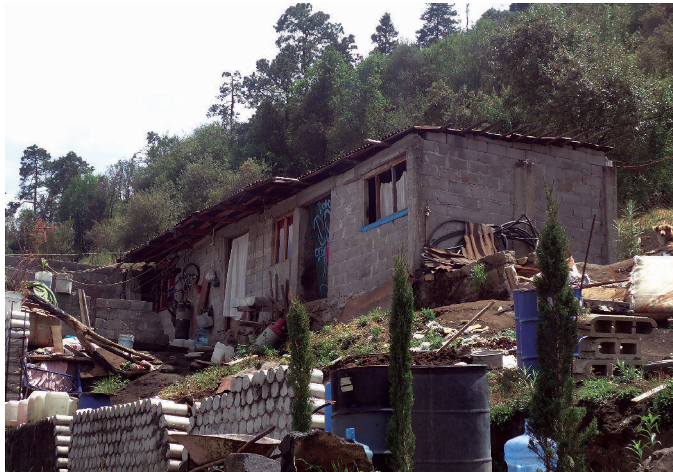
Figura 5.47. Fotografía A en el polígono de vulnerabilidad. Vivienda construida sobre ceniza volcánica. Frente a la vivienda hay muros de contención improvisados de tipo gravedad, desarrollados con núcleos de concreto que mitigan el desplazamiento de material (19.2179° N, 99.2227° W. Carretera Picacho – Ajusco).
