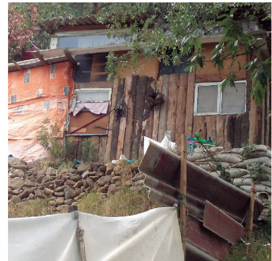
Vivienda desplantada sobre materiales inestables.
