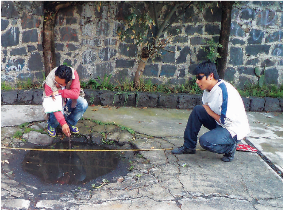
Figura 5.71. Fotografía A. Hundimiento concéntrico cubierto de asfalto y las fracturas que tiene la banqueta. Por las dimensiones, pareciera ser una coladera (19.2810° N, 99.2188° W. Calle: Conkal).
