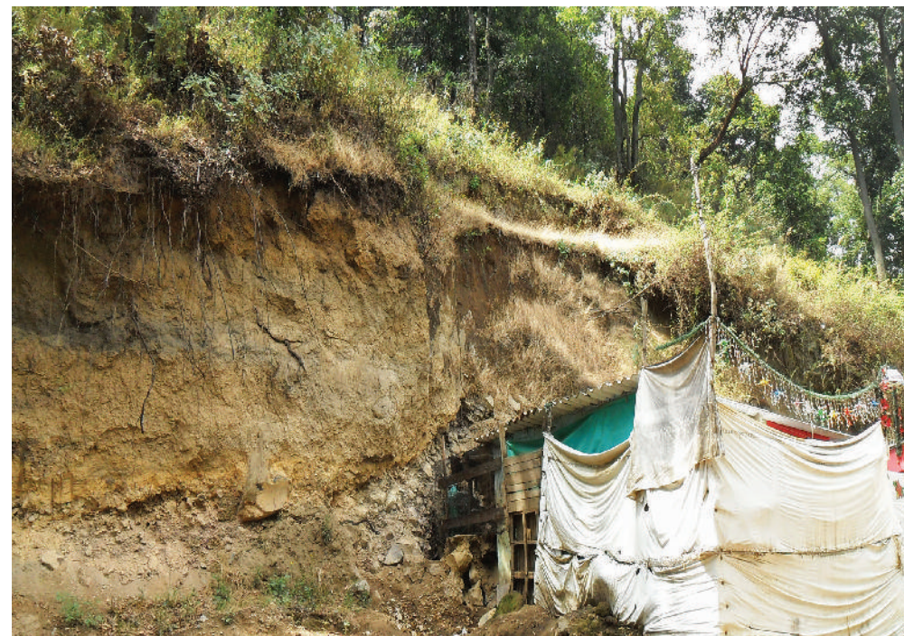
Figura 5.42. Fotografía A en el polígono de vulnerabilidad. Vivienda hecha de madera y lámina construida frente a un talud de material inestable y fácilmente erosionable. Esta vivienda se vería muy afectada ante un derrumbe o deslizamiento, ya que los materiales no tienen la resistencia para los empujes a los que se verían expuestos, además que no están articulados para trabajar como sistema, lo cual ocasionaría una falla frágil y súbita (19.8169° N, 99.1434° W. Calle: Prolongación Ayocaititla).
