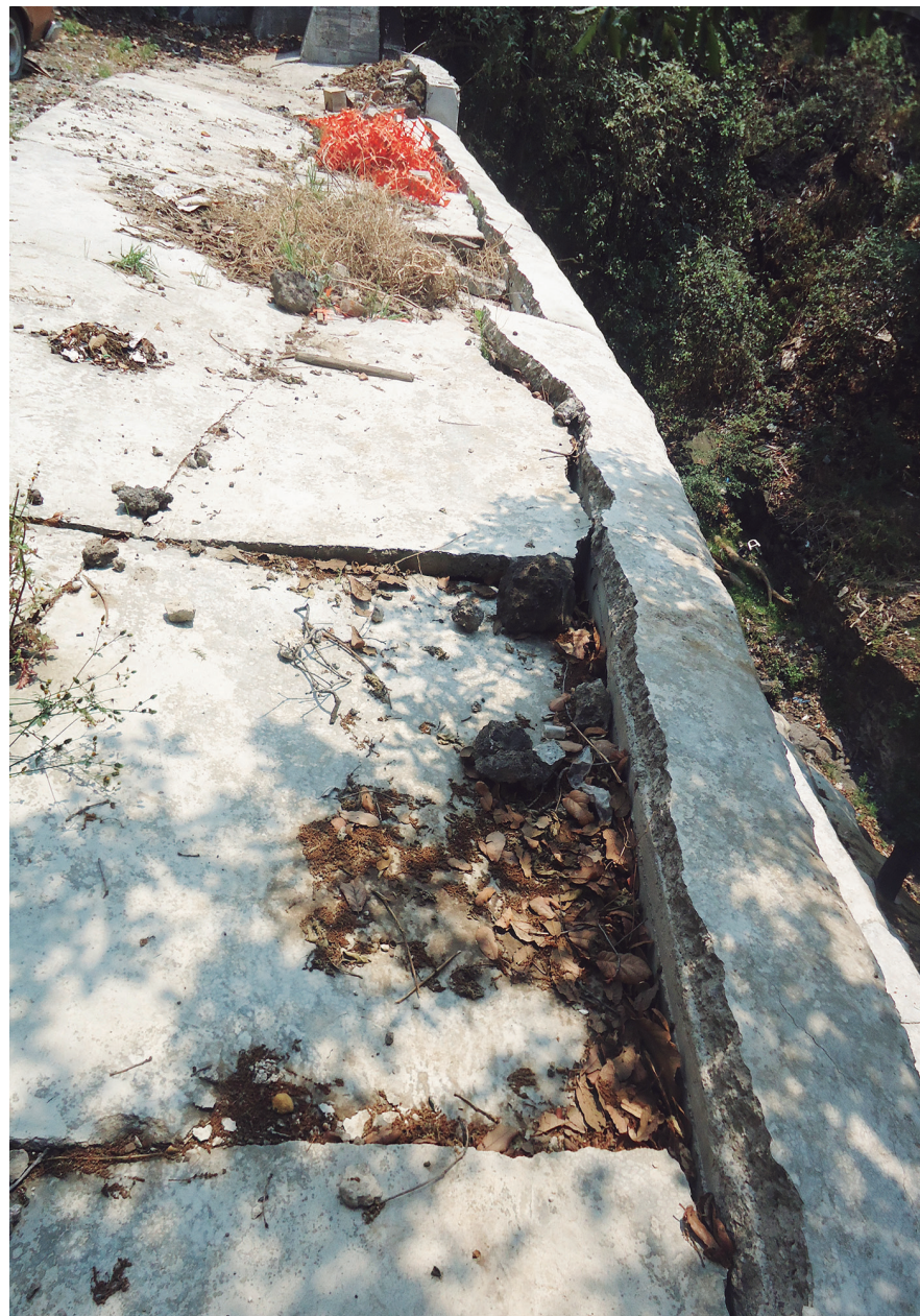
Figura 5.62. Fotografía B en el polígono de peligro. Parte baja del muro de contención de mampostería tipo gravedad en la calle Río Seco (19.7144° N, 99.2414° W. Calle: Río Seco).
