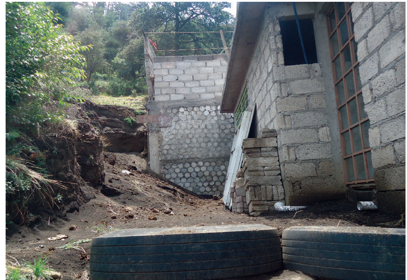
Figura 5.48. Fotografía B en el polígono de vulnerabilidad. Vivienda en construcción a base de sistema mixto. Del lado izquierdo hay un talud de origen antrópico con un deslizamiento de ceniza (19.2202° N, 99.2227° W. Carretera Picacho–Ajusco).
