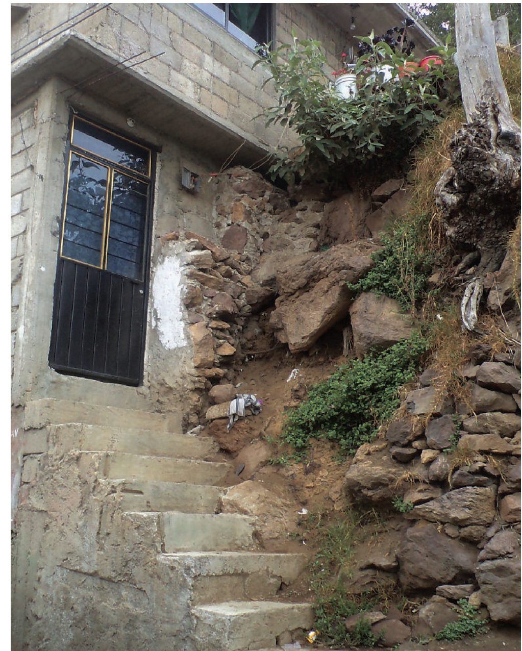
Figura 5.26. Fotografía B en el polígono de peligro. Bloques de roca expuestos con peligro de caída que se localizan en los cortes realizados sobre la ladera debido a la construcción de la vivienda (19.0487° N, 99.1457° W. Calle: Las Cruces).
