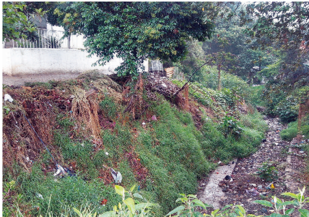
Figura 5.56. Fotografía A en el polígono de peligro. Los sedimentos y bloques de distintos tamaños que han sido transportados por el caudal han afectado por completo las obras de mitigación, lo que aumenta el peligro de flujos de lodo y rocas (19.9431° N, 99.2379° W. Calle: Ferrocarril De Cuernavaca).
