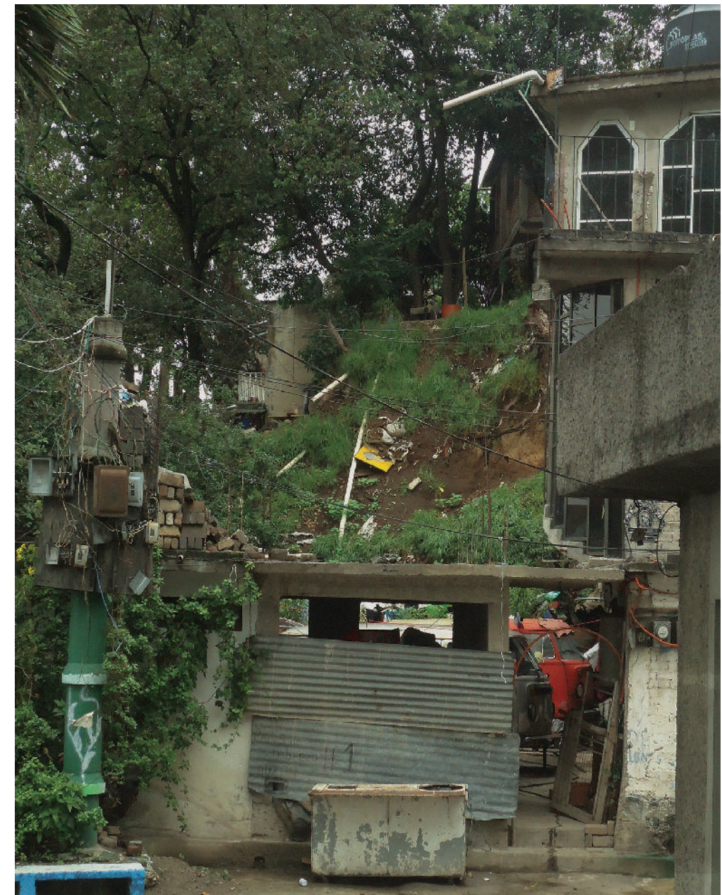
Figura 5.67. Fotografía A en el polígono de vulnerabilidad. Construcciones cercanas a una pendiente con escalones y áreas sin cubierta vegetal. Estas condiciones en el terreno representan un peligro alto para las viviendas localizadas en la parte baja (19.5020° N, 99.1756° W. Calle: 5 de Febrero).
