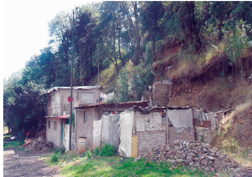
Figura 5.40. Fotografía A en el polígono de peligro. Los escarpes producidos por actividad antrópica representan un peligro alto por derrumbe y caída de rocas en la parte baja de la ladera del polígono de Ayocaititla (19.8152° N, 99.1440° W. Calle: Prolongación Ayocaititla).
