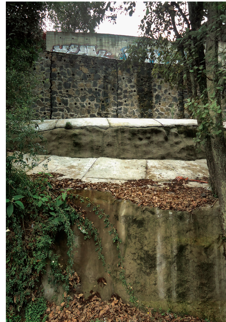
Figura 5.63. Fotografía A en el polígono de vulnerabilidad. Vista de la parte superior del muro de contención. Se pueden observar fracturas que obedecen a un desplazamiento a favor de la pendiente (19.7189° N, 99.2414° W. Calle: Río Seco).
