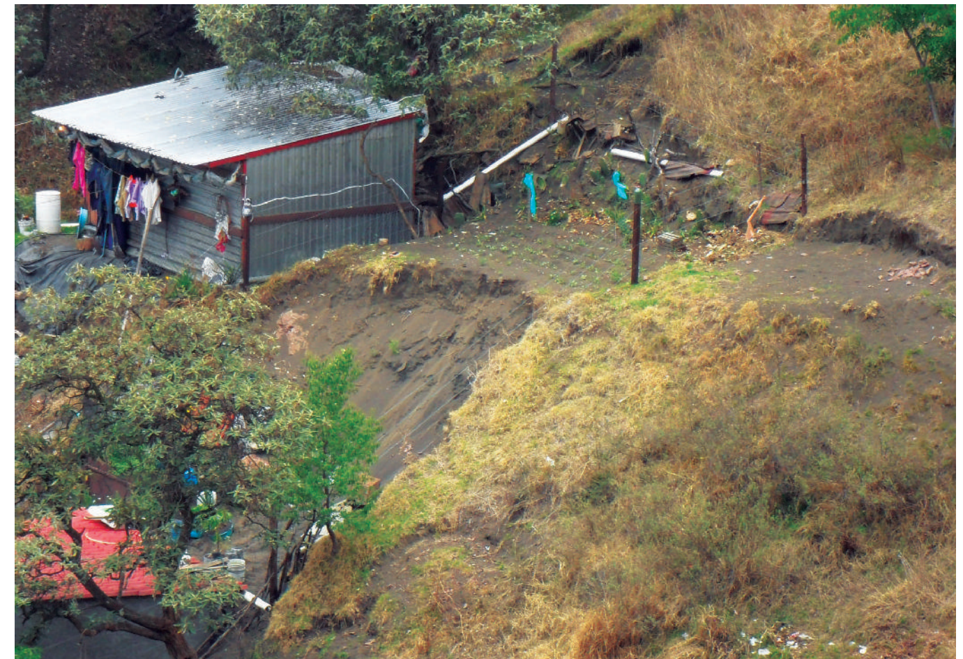
Figura 5.28. Fotografía A en el polígono de vulnerabilidad. La ceniza, al ser un material muy deleznable, es removida fácilmente, en especial en los taludes hechos para viviendas, ya que se reduce el nivel de estabilidad de los materiales. En la fotografía se puede apreciar la gran actividad que se presenta en los escarpes (19.0735° N, 99.1393° W. Calle: Independencia).
