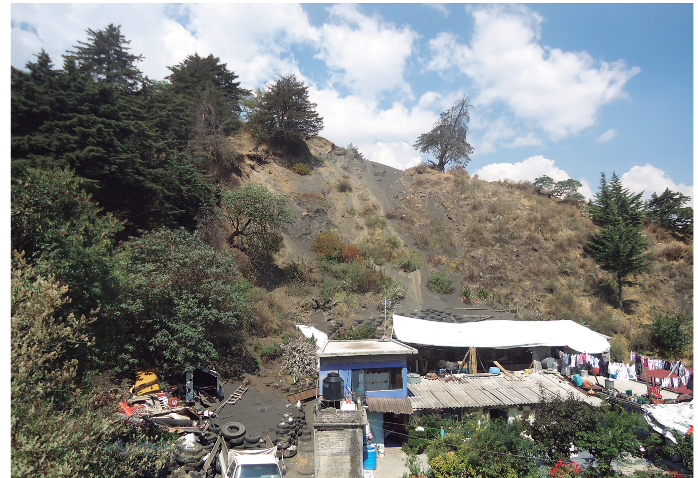
Figura 5.21. Fotografía E en el polígono de vulnerabilidad. La falta de vegetación favorece la erosión y remoción de la ceniza volcánica del suelo. El material desplazado por dicho fenómeno invade el patio de la vivienda, pese al muro de contención (construido con llantas) que ha sido levantado en varias ocasiones (19.3374° N, 99.1841° W. Calle: Río Seco).
