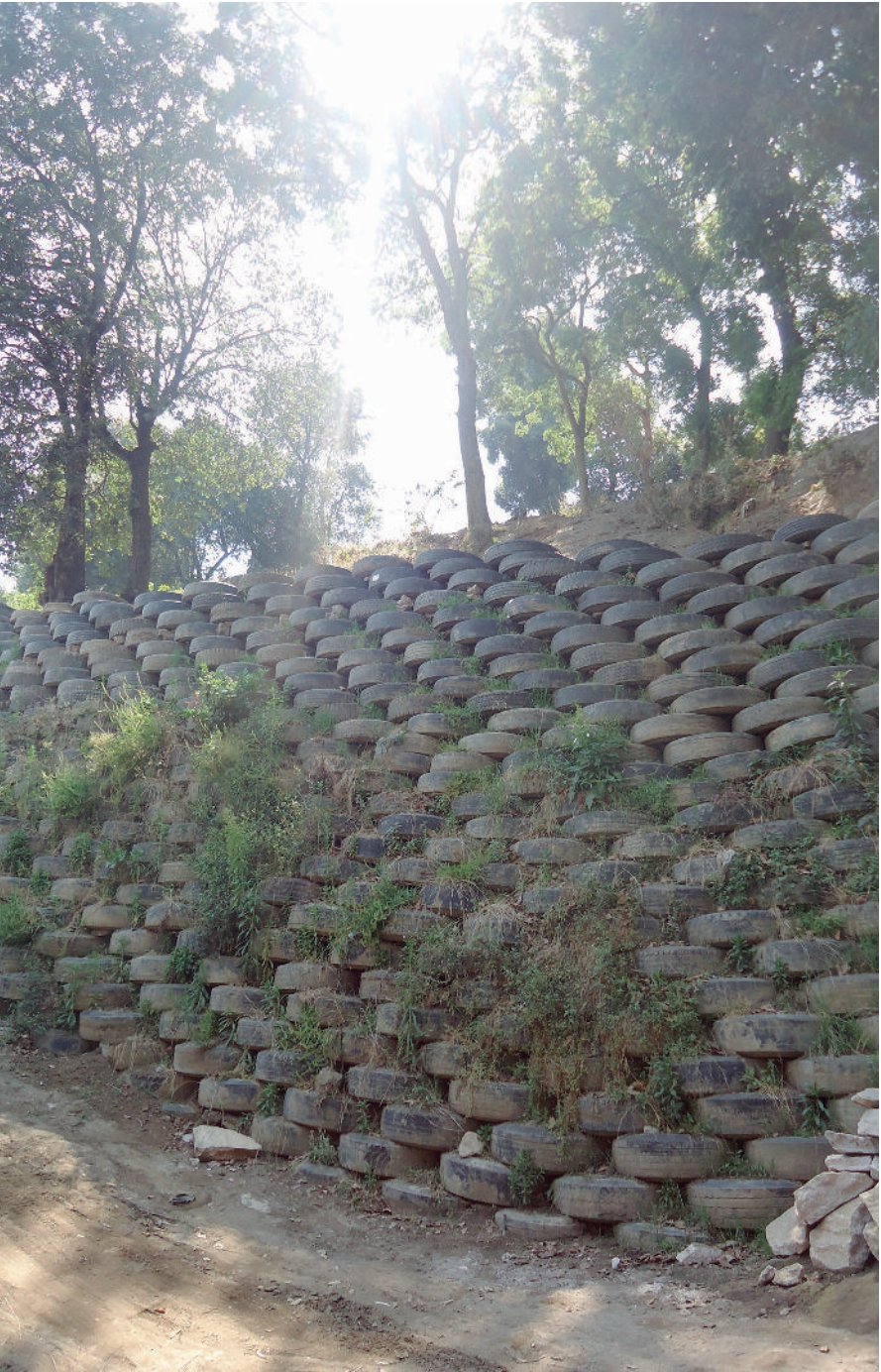
Muro de contención hecho con llantas para poder detener los materiales inestables.
